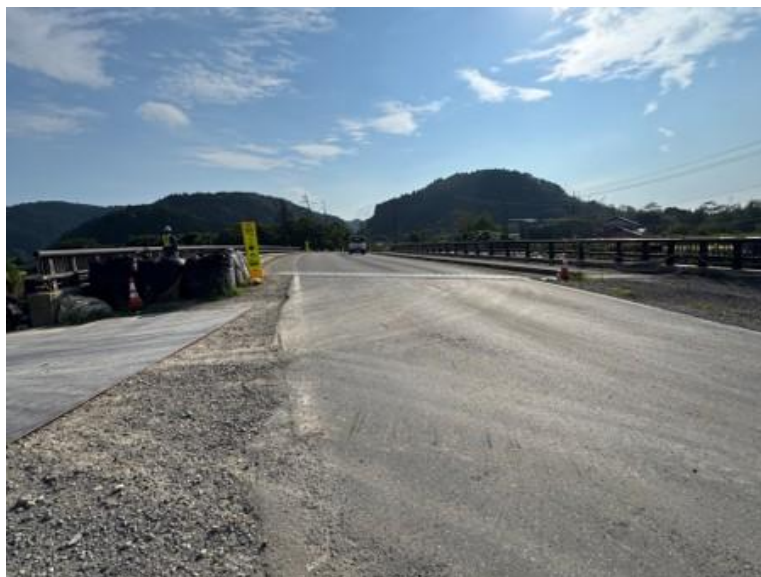
<天神橋 進捗状況写真>
